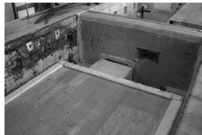
床上面加熱試験の試験体
