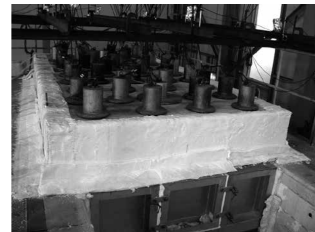
床下面加熱試験の試験体
