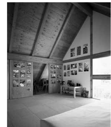
図49 登りばり方式の屋根 (写真提供: サイト・アーキテクト+小口亮建築計画事務所)
