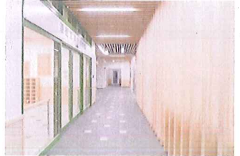
間仕切りにヒノキ、天井ルーバーが不燃済みのヒノキ
