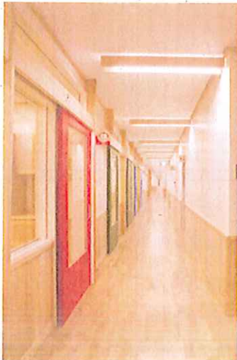
腰壁と照明BOXはヒノキ
