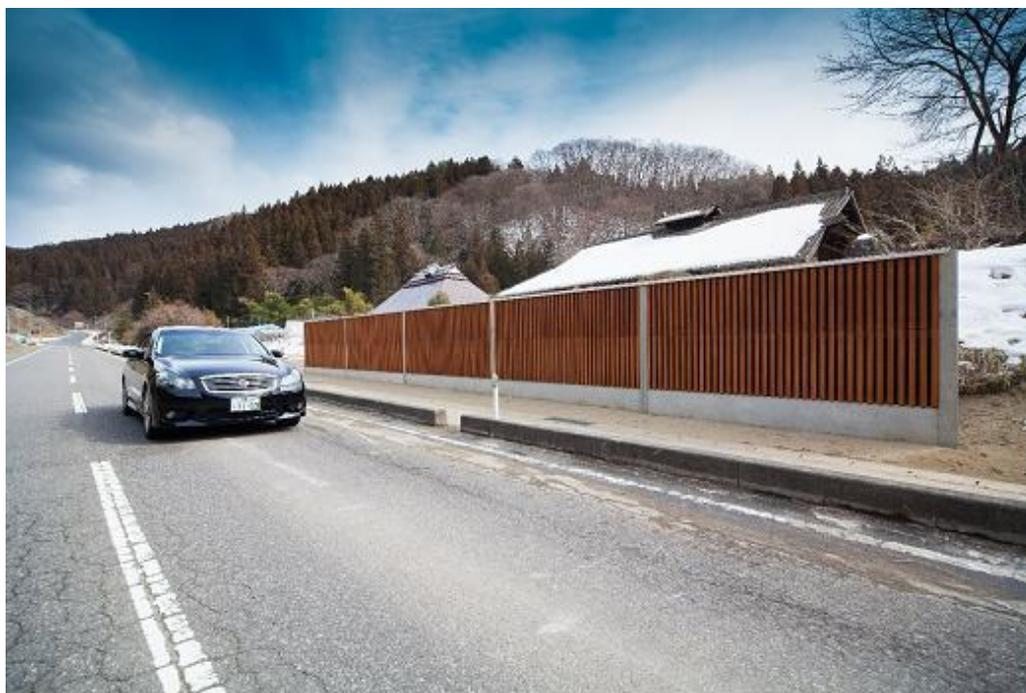
図 2 6. 完成した遮音壁前
