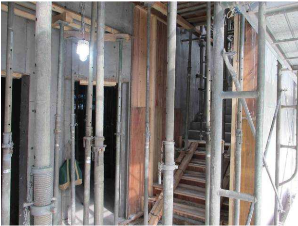
打設現場の様子
