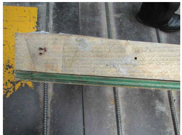
打設後の型枠パネル側面
