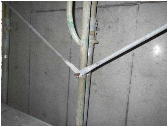
地域材型枠合板打設面
