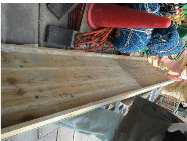
打設後の合板裏面
