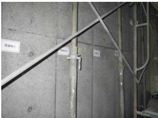
地域材型枠合板打設面(調査 No.1～4)
