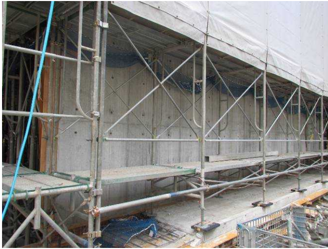
南洋材型枠合板打設現場
