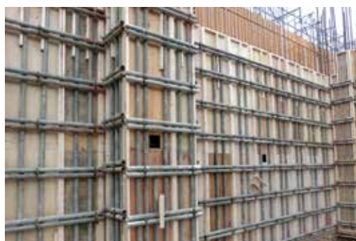
外壁の建て込み状況
