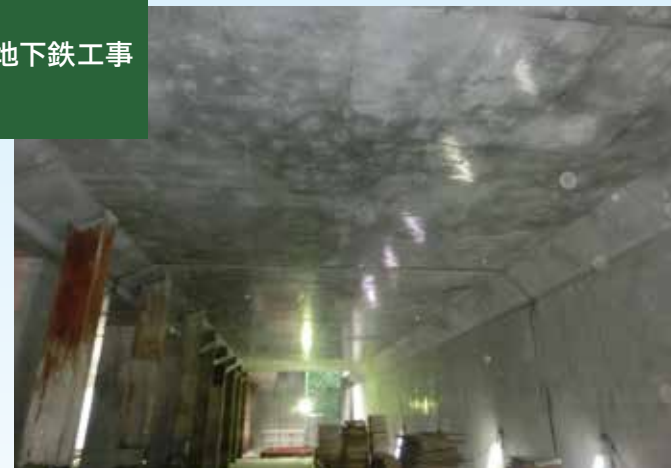
ボックスカルバートの天井部分
