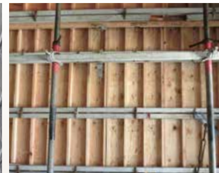
内壁建て込み
