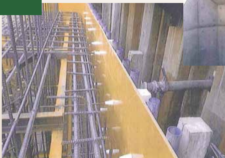
橋台（国産材型枠）
