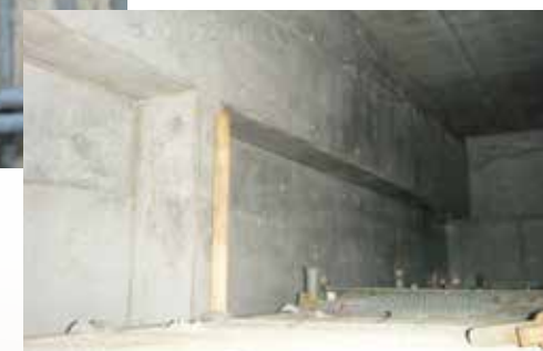
地下1階外周壁 (国産材型枠 脱型後のコンクリート表面)
