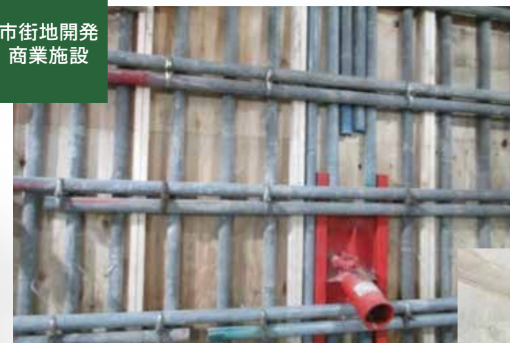
地下1階の内壁建て込み
