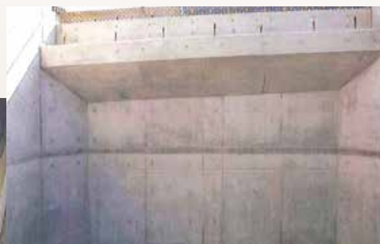
国産材型枠のコンクリート表面
