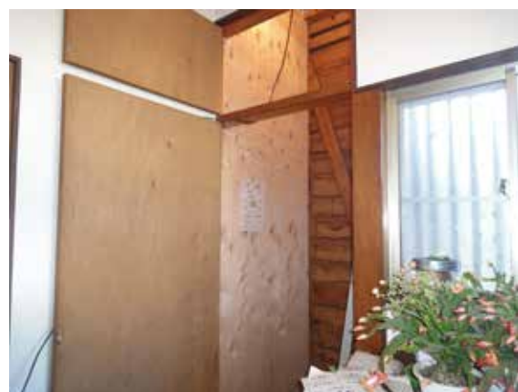
写真7-14 押入れ入隅部の補強の様子
