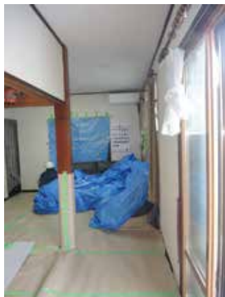
写真7-1 壁の新設-1 (独立柱の右側を耐力壁に変更)
