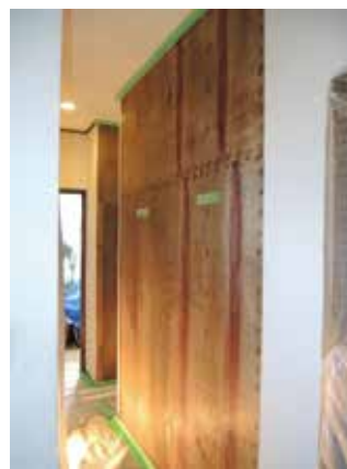
写真7-10 壁の補強②-6 (合板張り耐力壁の施工完了)
