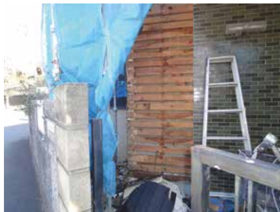
写真7-12 外壁の補強前
