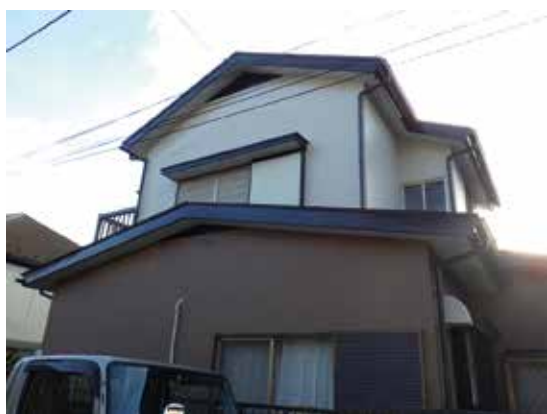
写真7-15 耐震補強後 全景
