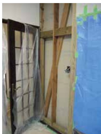
写真7-3 壁の補強①-1 (内壁の筋かい壁に合板を増設)
