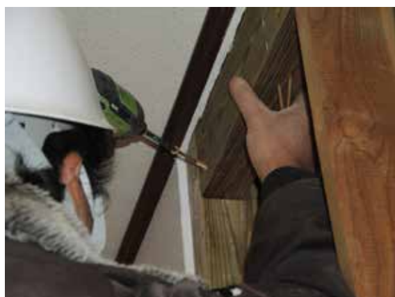
写真7-9 壁の補強②-5 (受材の施工)
