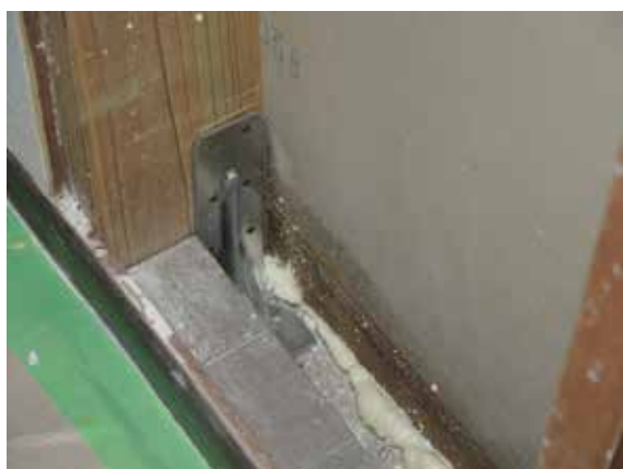
写真7-7 壁の補強②-3 (柱脚部に金物を設置)
