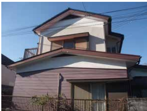
写真7-11 耐震補強前 全景
