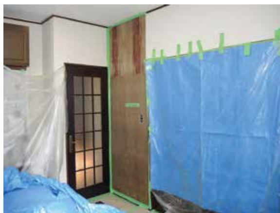
写真7-4 壁の補強①-2 (合板張り耐力壁の施工完了)
