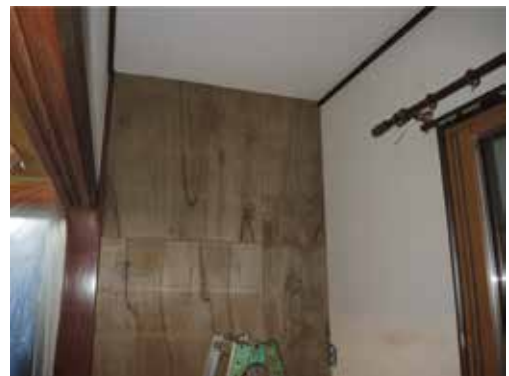
施工箇所の写真
