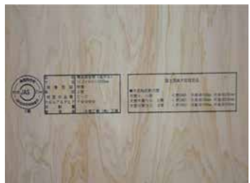
耐震補強で使用した合板のJAS印、メーカー名が見える写真
