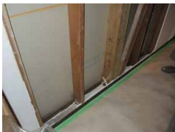
写真7-6 壁の補強②-2 (内壁の仕上げを撤去したところ。左手前が非耐力壁、右奥が筋かい壁)
