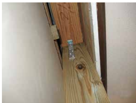
写真7-8 壁の補強②-4 (柱頭側に金物を設置)
