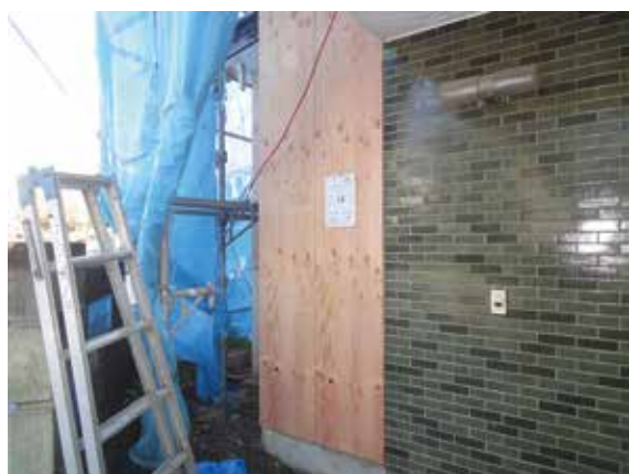
写真7-13 外壁の補強後
