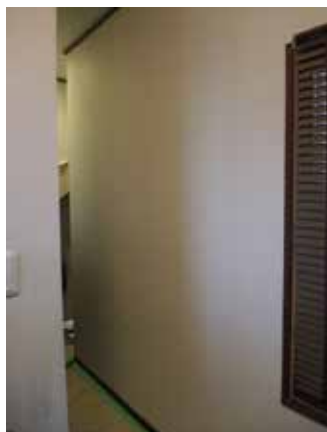
写真7-5 壁の補強②-1 (内壁に合板補強を施す前の状態)
