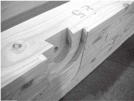
図 17. 桁仕口の加工
