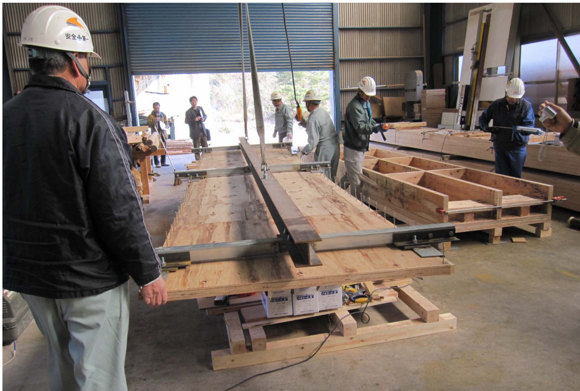
SSP試験体の製造工程
