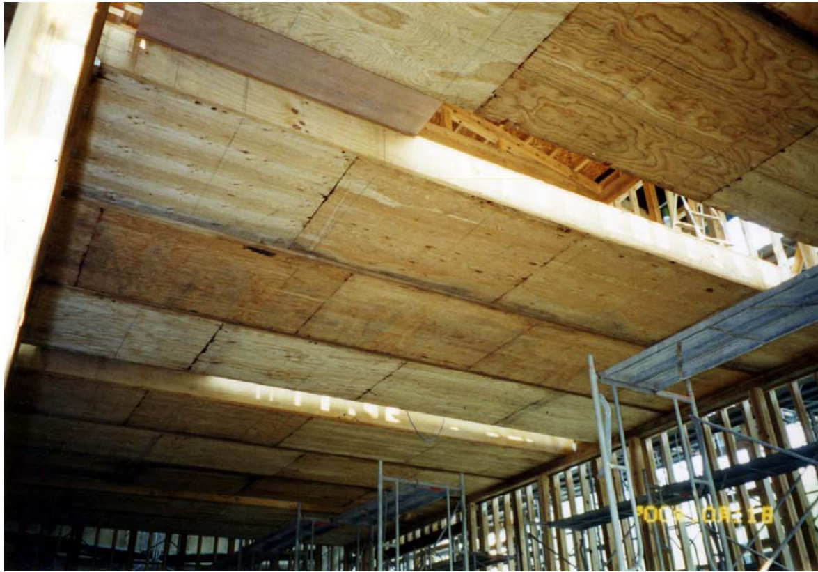
左写真： 岐阜県立森林文化アカデミー マルチメディア実習棟の 2階床 LVLストレストスキンパネル
