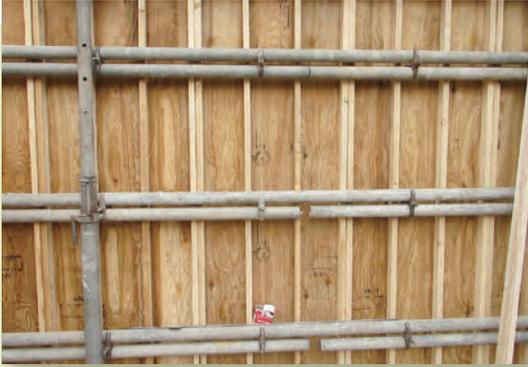
1階建てこみ(2x6の縦使いで、8階までラワン型枠用合板と同じ施工)
