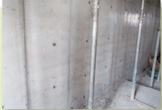
8階コンクリート表面(ラワン型枠用合板と同じ仕上がり)
