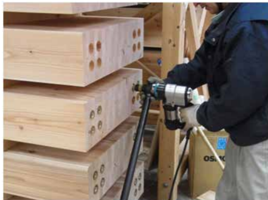
写真1 LSBの施工状況
