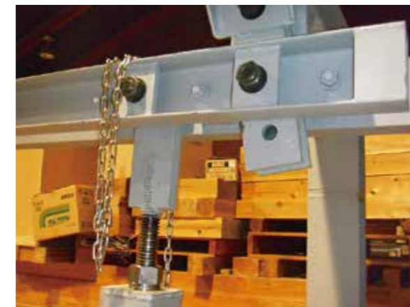
写真 5 アーム支点部
